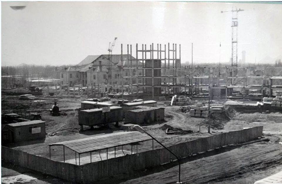
Общий вид строительной площадки МИСИ, 1972 г.
