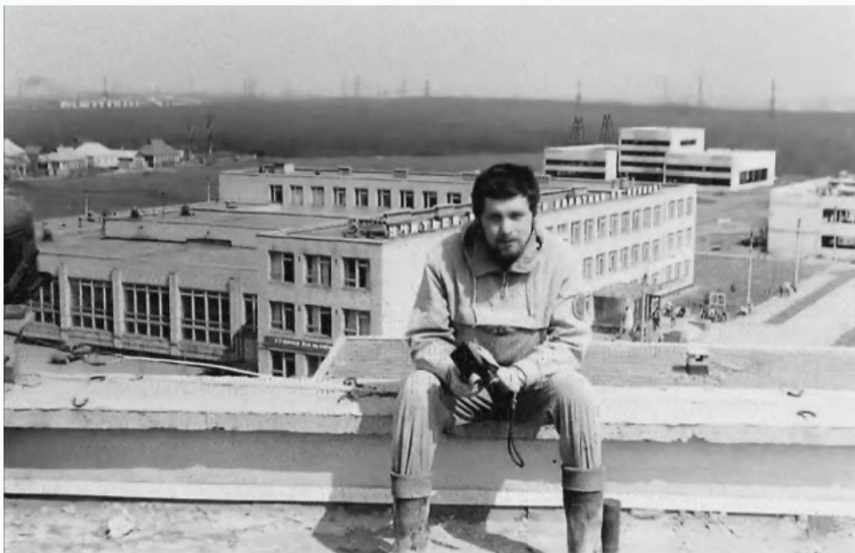
На крыше строящегося корпуса №1, Ассеев Б.Н., 1976 г.
