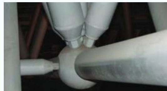
Шаровый узел структуры фирмы «MERO» (Германия) над трибунами
