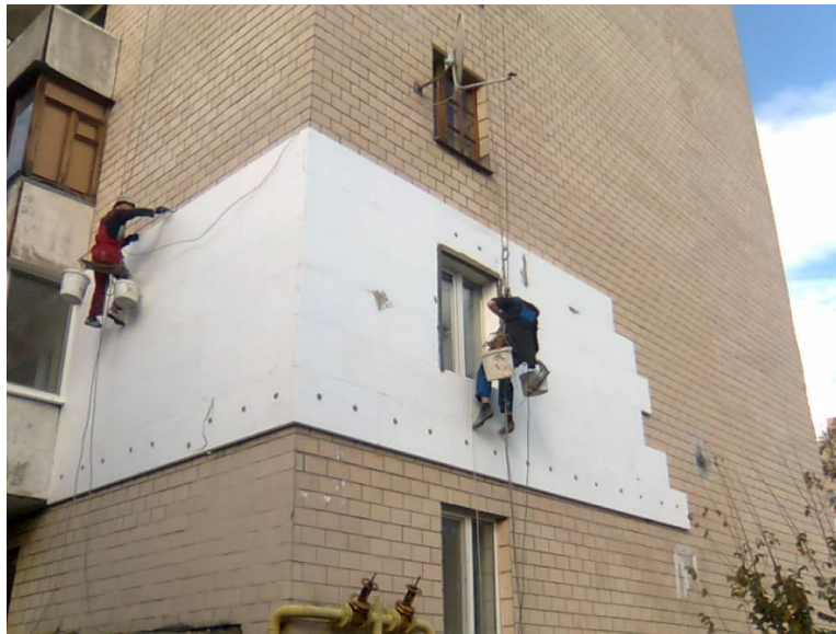
Рисунок 1.2 – «Точечное» утепление
