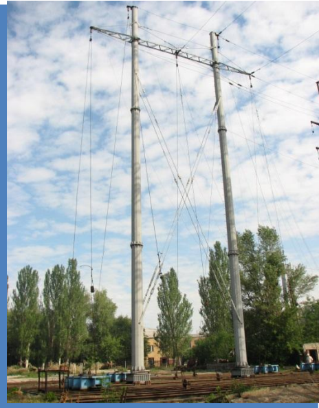
Нагрузочные испытания промежуточной опоры ПМГ 330-28
