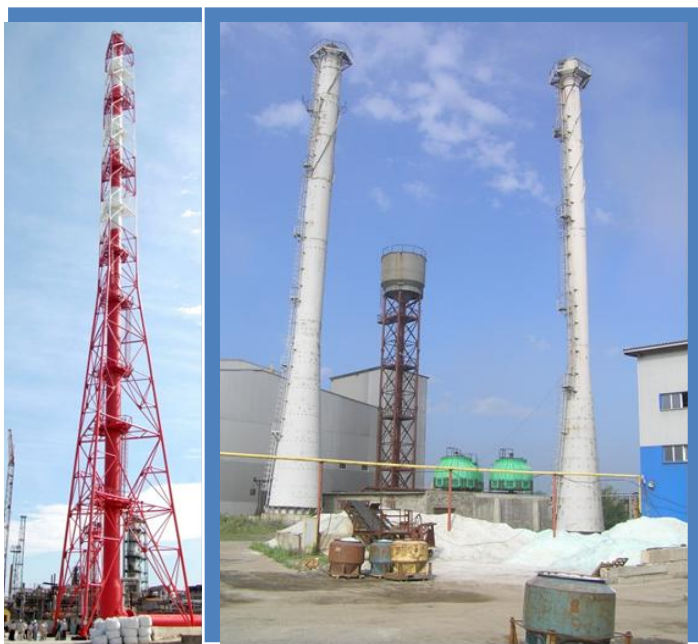
дымовая труба 120 м
