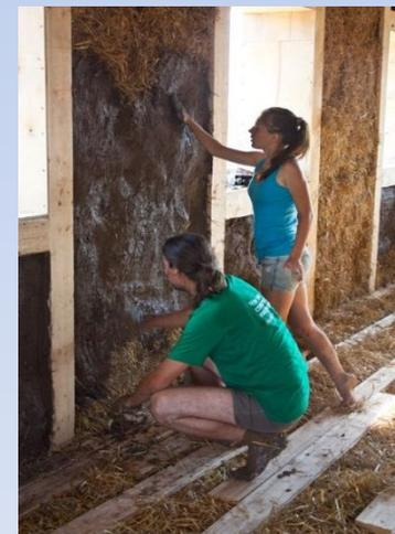
Процесс монтажа армосетки и штукатурки
