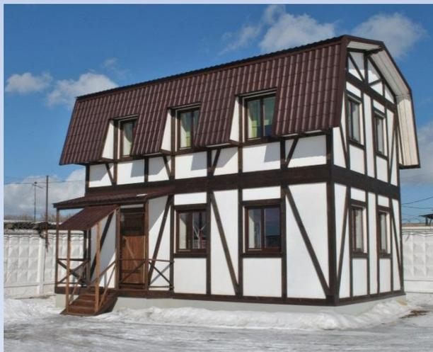
Пример двухэтажного жилого дома на основе каркаса с заполнением его блоками из соломы
