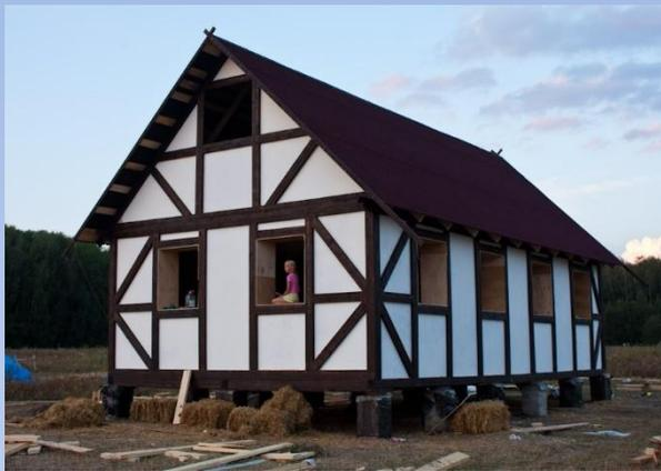
Пример одноэтажного жилого дома на основе каркаса с заполнением его блоками из соломы
