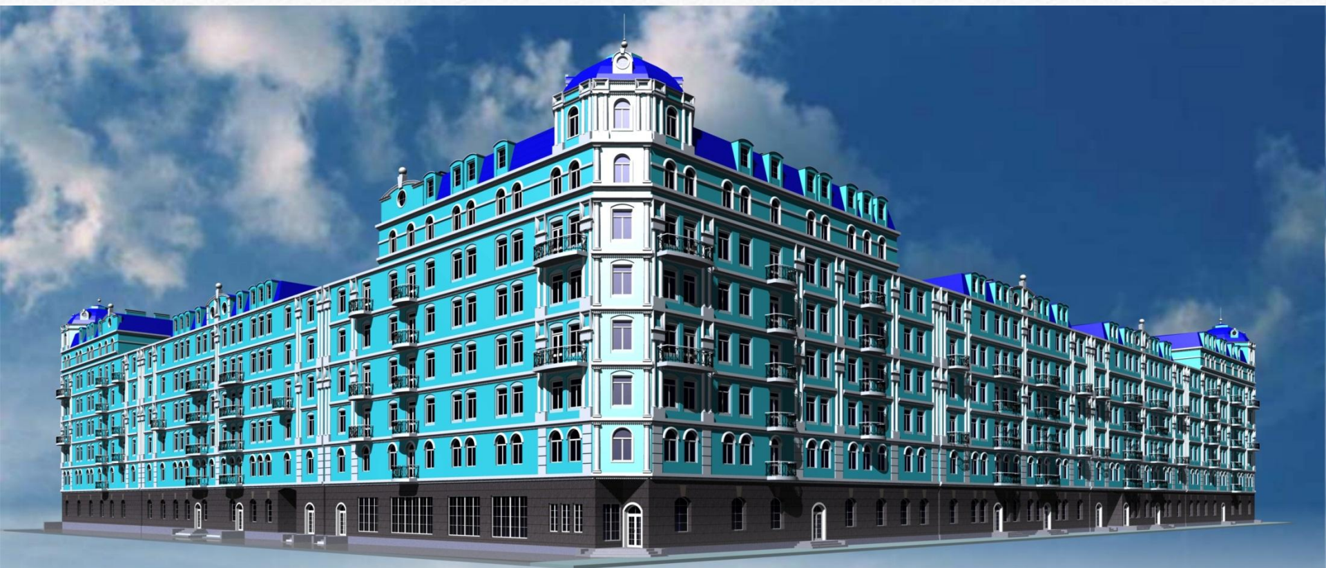
Г. Керчь. Общий вид многоквартирного дома с объектами обслуживания
