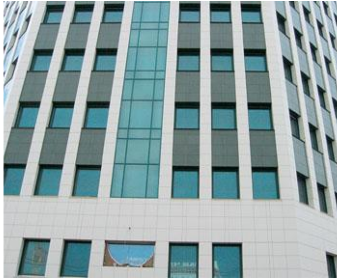
Рисунок 2 - Пример здания с вентилируемым фасадом и с многочисленными оконными простенками
