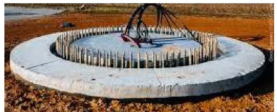
Рис. 1. Фундамент ВЕУ типа «Vestas» міцністю 3,0МВт ВЕС Старий Самбір у Львівській області.
