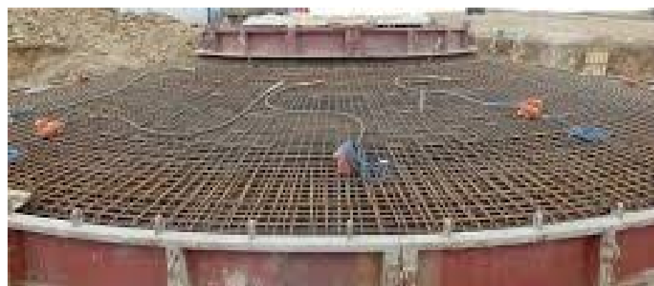
Рис. 1. Фундамент ВЕУ типа «Vestas» міцністю 3,0МВт ВЕС Старий Самбір у Львівській області.
