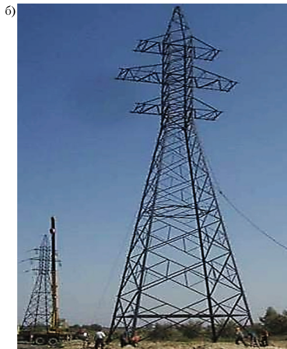
Рисунок 5. Оптимальная двухцепная анкерно-угловая опора У110-2+14: а) в процессе стендовых испытаний У110-2+9; б) общий вид смонтированной опоры на линии.
