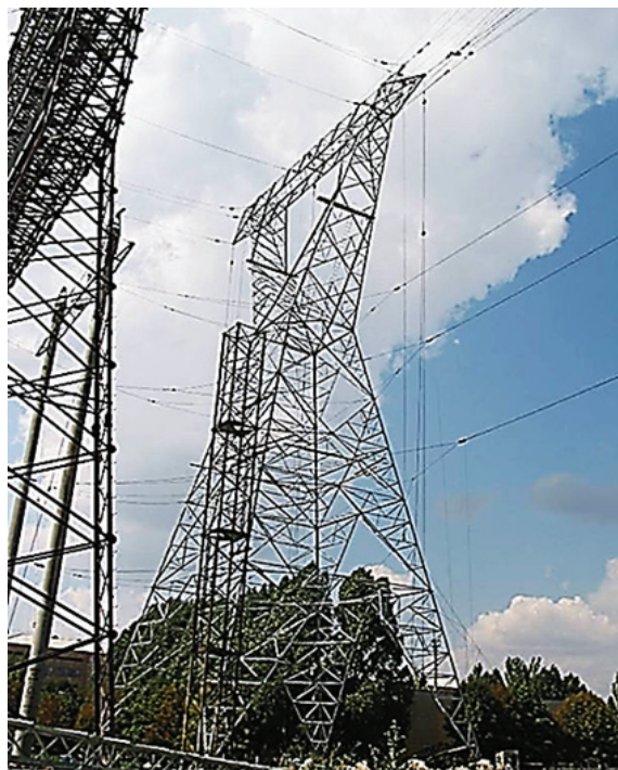
Рисунок 13. Одноцепная опора S-МС+6 (Сирия).
