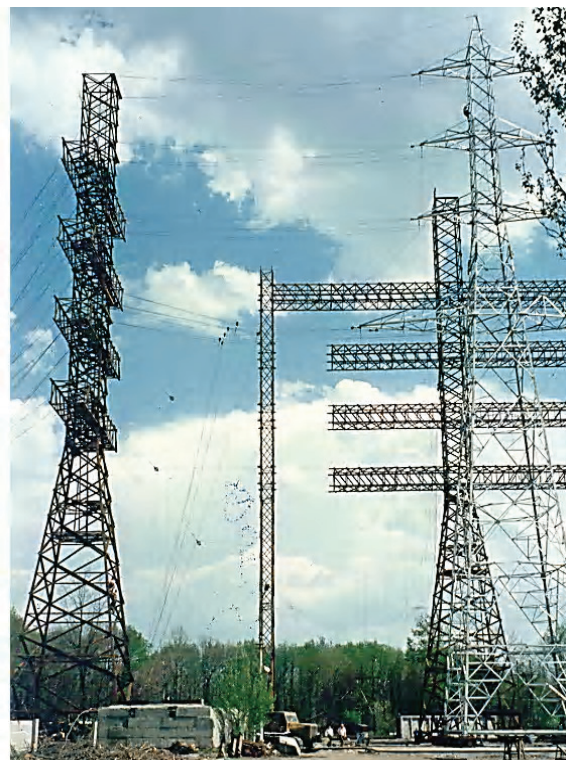
Рисунок 1. Промежуточная четырехцепная опора MSE-12 (Египет), первая опора, испытанная на Полигоне в мае 1997 г.
