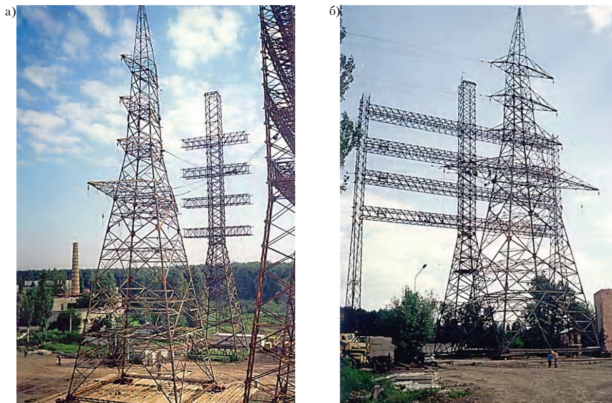
Рисунок 2. Анкерно-угловая четырех цепная опора MSE-90 весом 54 т высотой 60 м (Египет): а) нормальный режим; б) аварийный режим.
