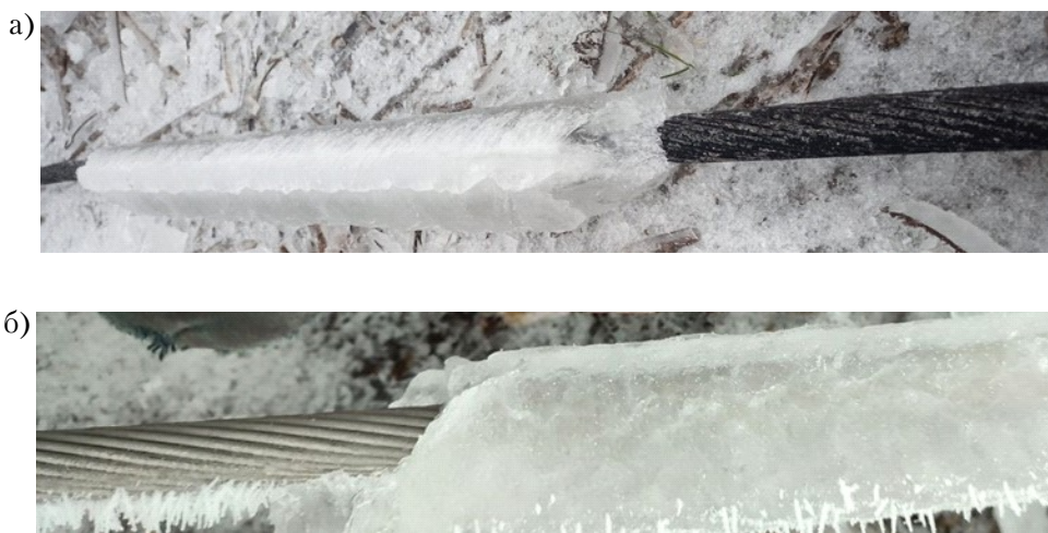
Рисунок 6. Гололёдные отложения на проводах ВЛ при технологических нарушениях в период 11–16.12.2023: а) толщина стенки льда до 40 мм на ВЛ 110 кВ СБТЭС – Еленовка тяговая № 1 и 2 (условия образования: t = -2 °С, ветер – 6–12 м/с, осадки – заморающий дождь); б) толщина стенки льда до 50 мм ВЛ 110 кВ Дмитриевка – Волноваха тяговая (условия образования: t = -1 °С, ветер – 5–10 м/с, осадки – мокрый снег).
