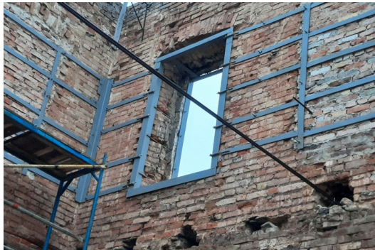
Рисунок 8. Усиление металлическими обоймами стен здания церкви Иоанна Кронштадтского, имеющего значительные повреждения.
