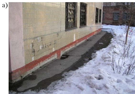
Рисунок 4. Детского сада № 405 в Калининском районе, г. Донецк. а) проседание и разрушение отмостки вокруг здания, уклон отмостки в сторону здания. Вентиляционные приемки не защищены от проникновения в подвал атмосферных осадков; б) отклонение стены детского сада № 405 по оси «А» от вертикали на 70 мм.
