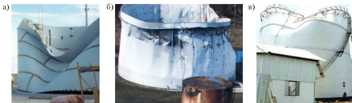
Рисунок 2. Аварии резервуаров без стационарной кровли.
