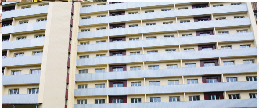
Реконструкция двух зданий бывшего общежития по ул. Розы Люксембург 2 и 2 а
