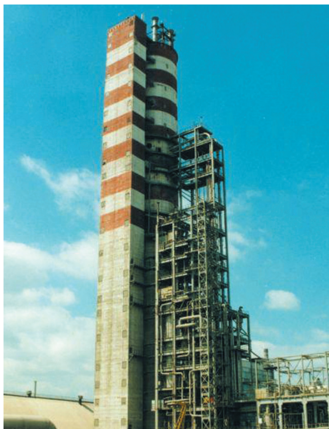
Фото 3. Грануляционная башня производства нитроаммофоски НРК на Новгородском химическом комбинате «СОЮЗАЗОТ»
