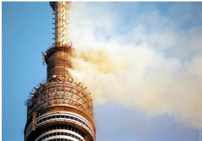
Фото 5. Пожар на радиопередающей станции телевидения «Останкинская телебашня», 27–28 августа 2000 года
