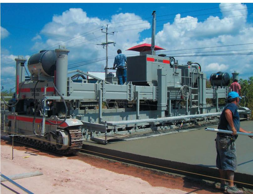
Рис. 1. Бетонирование дорожного полотна слипформером
