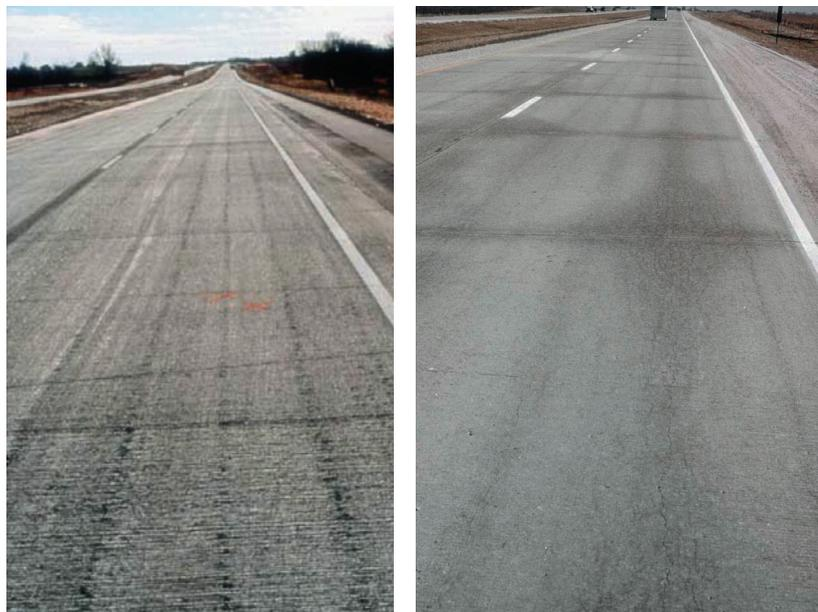
*Рис. 2. Продольные контуры («вибрационные дорожки») на поверхности цементбетонного покрытия*
