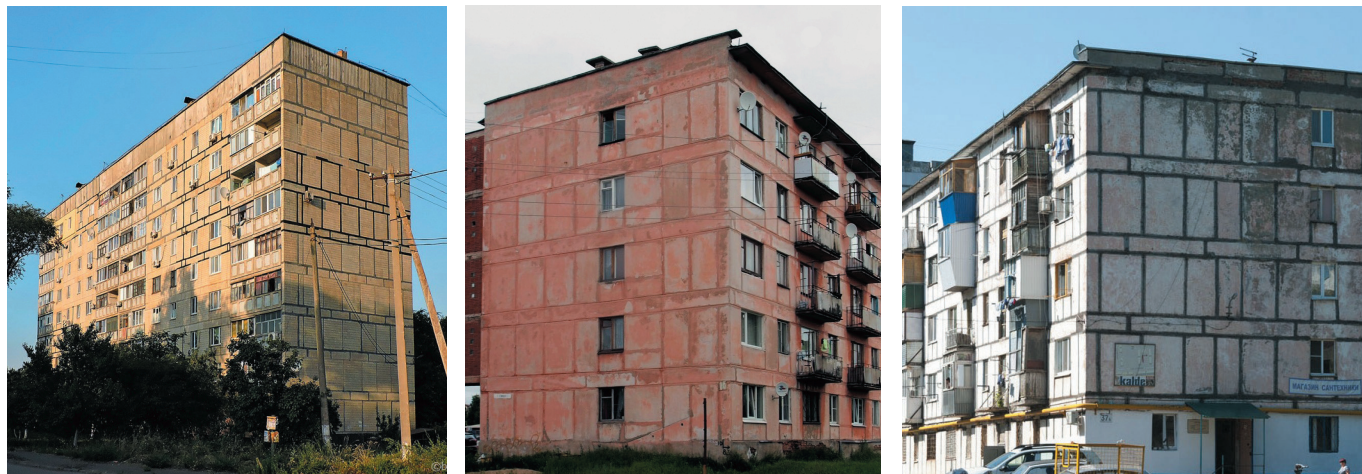
Рис. 1. Типы КБ зданий, различные по высоте, разрезке стен, виду материала изготовления стен
