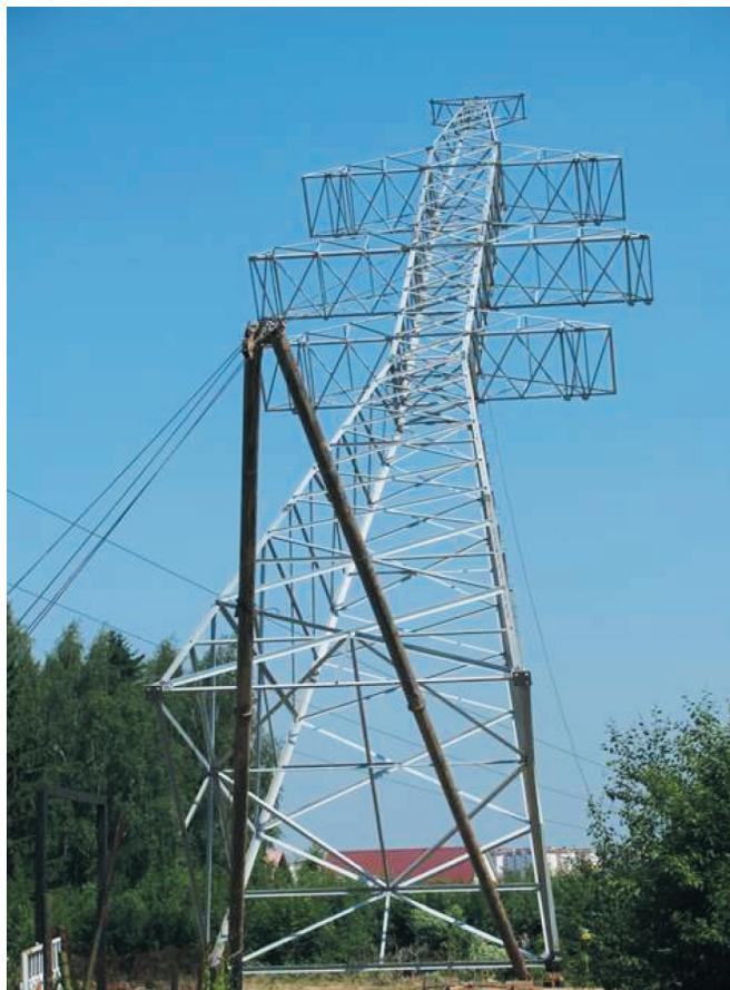
Рис. 1. Монтаж опоры ЛЭП с помощью падающего шевра
