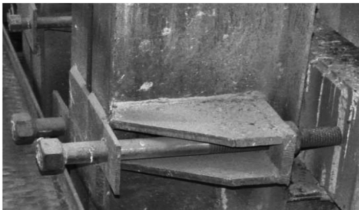
Рис. 5. Тяж в реальной конструкции
