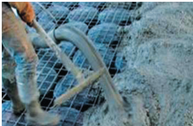
Рис. 2. Процесс бетонирования фундаментной плиты с применением опалубочной системы «Iglu»
