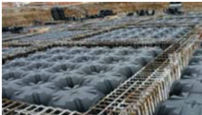
Рис. 1. Совмещение армирования фундаментной плиты с системой «Мультимодуло»
