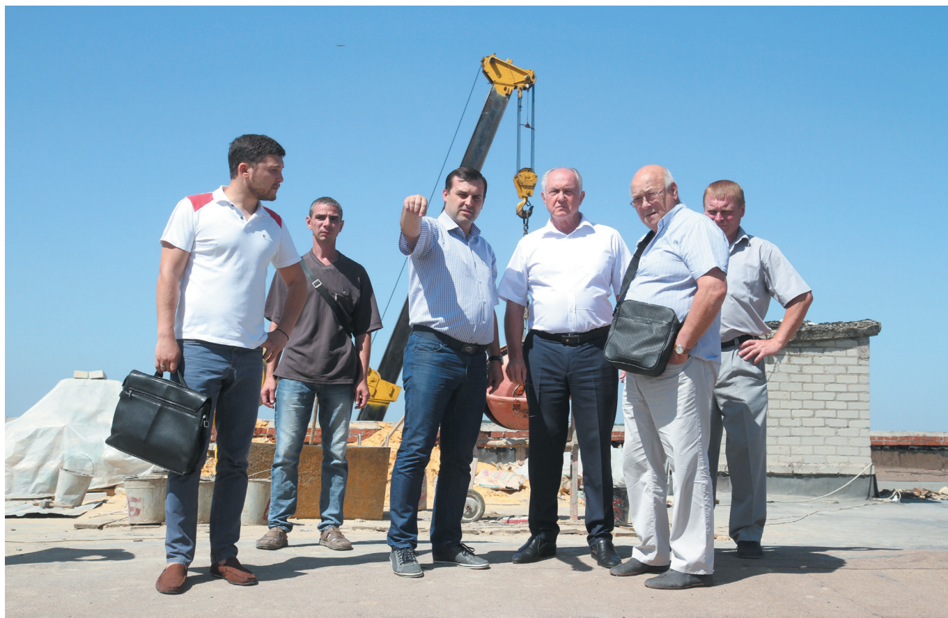
Контроль за выполнением кровельных работ
