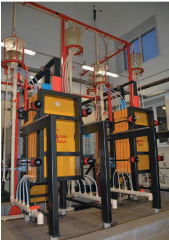
*Рис. 3. Станция обеззараживания в Каменск-Уральском ОАО «Водоканал» установками МБЭ производства ООО ГК «Спецмаш»*
