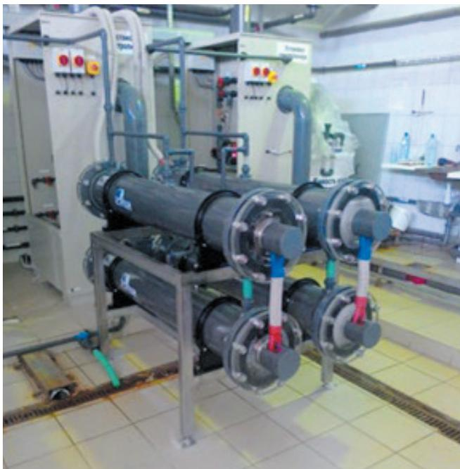
*Рис. 1. Четыре электролизера «Хлорэкс» взамен вышедшим из строя «GRUNDFOS/ALLDOS» производительностью 150 кг хлора в сутки каждый*
