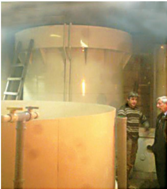
*Рис. 1. Аэротенк-осветлитель с затопленной эрлифтной системой аэрации на рыбной фабрике, пгт. Пантелеймоновка*
