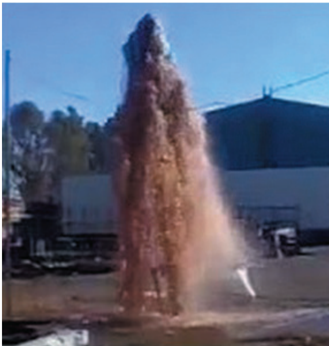
На фото: обработка скважины методом пневмовзрыва
