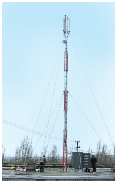
а) мачта с решетчатым стволom и двумя уровнями оттяжек
