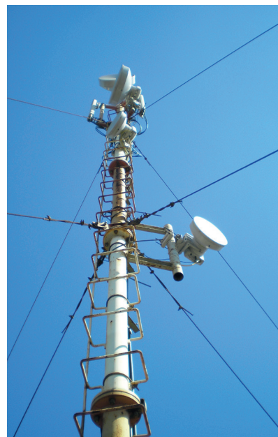
в) мачта с трубчатым стволom
