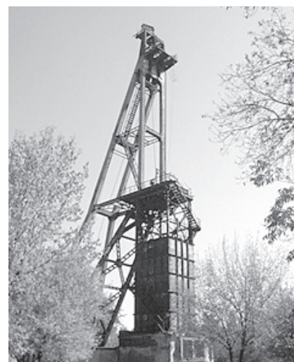
Рис. 11. Шахтный копер после реконструкции
