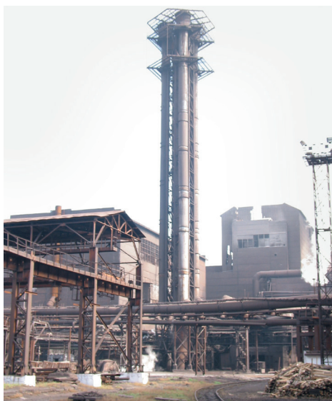
а) трехрожковая свеча дожигания высотой 80 м с наружными газоотводящими стволами
