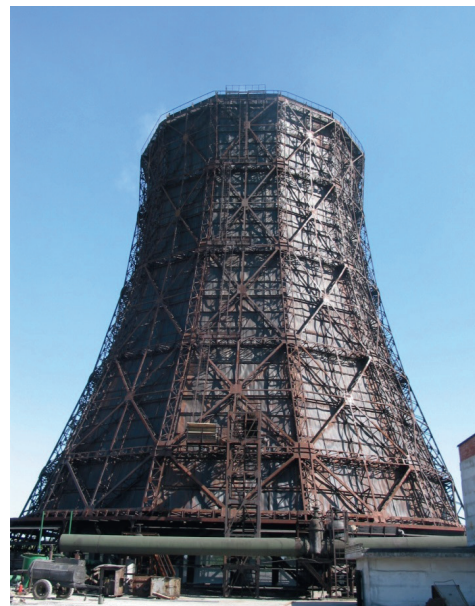
б) башенная решетчатая градирня высотой 52,3 м
