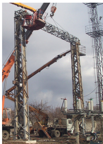
Рис. 3. Примеры выполненных работ по реконструкции с целью продления ресурса порталов и стоек под оборудование ОРУ
