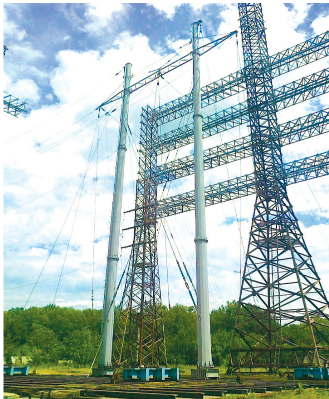
Рис. 11. Общий вид опоры ПМГ 330-28 нового типа во время испытаний на Полигоне ДОННАСА
