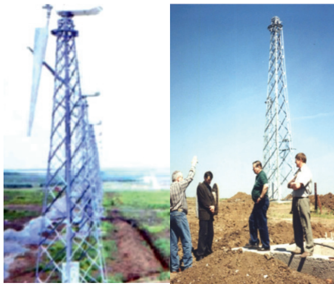
Рис. 14. Исследования анализа ветровых течений на площадке строительства Новоазовской ветроэлектростанции
