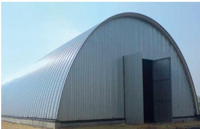
Следует отметить, что такие здания обладают большей несущей способностью за счет применения стального профилированного листа с двойным гофрированием с соединением на болтах, но обладают большей материалоемкостью и трудоемкостью монтажа.
