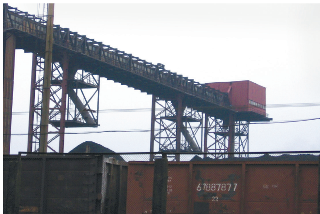
Рис. 7. Общий вид моста галереи Зуевской ТЭС
