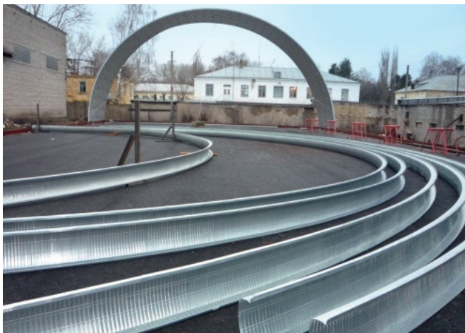
Рис. 1. Бескаркасное здание из гофрированных лоткообразных стальных профилей на момент возведения
