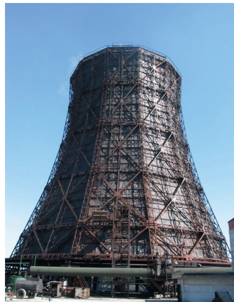
б) башенная решетчатая градирня высотой 52,3 м
