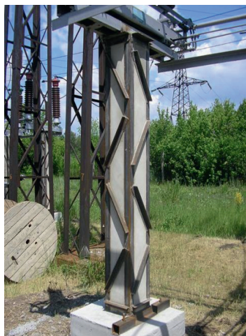
Рис. 3. Примеры выполненных работ по реконструкции с целью продления ресурса порталов и стоек под оборудование ОРУ
