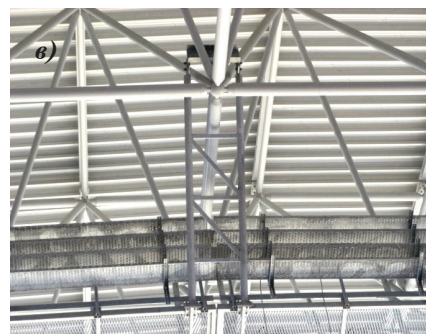
Рис. 5. Прикладные исследования и проектные разработки для стадиона «Донбасс-Арена»: а – конструкции крепления инфракрасных тепловых горелок к покрытию стадиона, б – теоретические и технологические основы технической диагностики и системы мониторинга, в – система мониторинга технического состояния металлоконструкций покрытия
