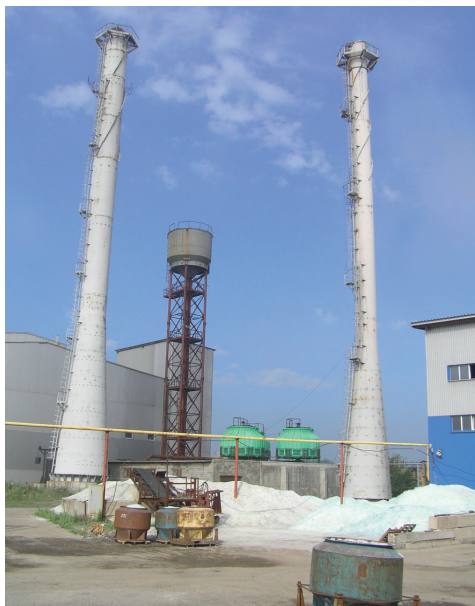
а) дымовые трубы и водонапорная башня
