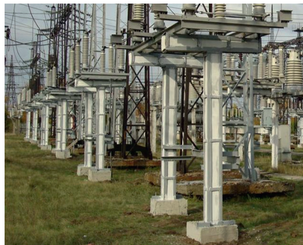
Рис. 3. Примеры выполненных работ по реконструкции с целью продления ресурса порталов и стоек под оборудование ОРУ
