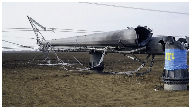
Рис. 10. Диверсия (подрыв опор) на ВЛ 330 кВ на энергоперетоке «Украина – Крым», 20.11.2015
