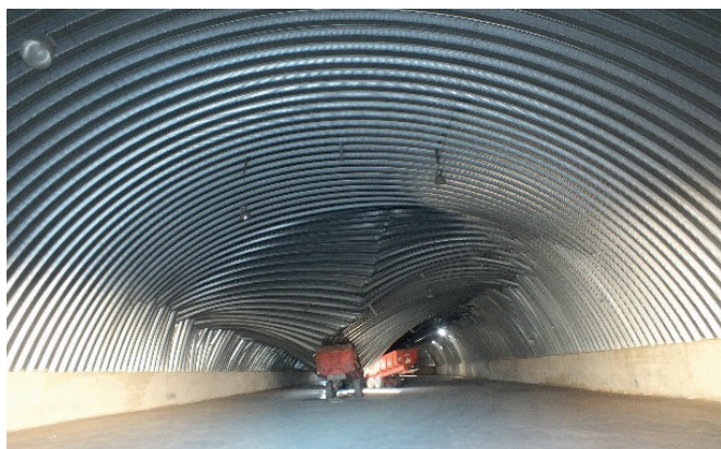
Рис. 5. Обрушение арочного здания сельскохозяйственного назначения (Липецкая область)
