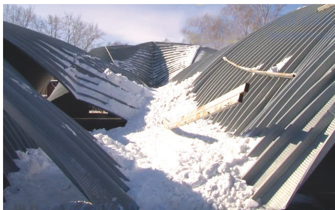
Рис. 4. Разрушение арочного здания автостоянки (г. Иркутск) (по материалам АС Байкал ТВ)
