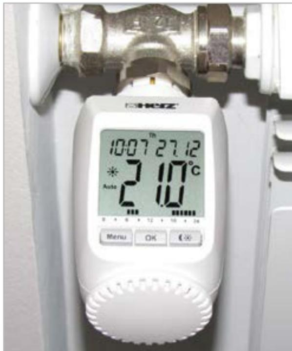
Рис. 3. Автоматический терморегулятор системы водяного отопления
