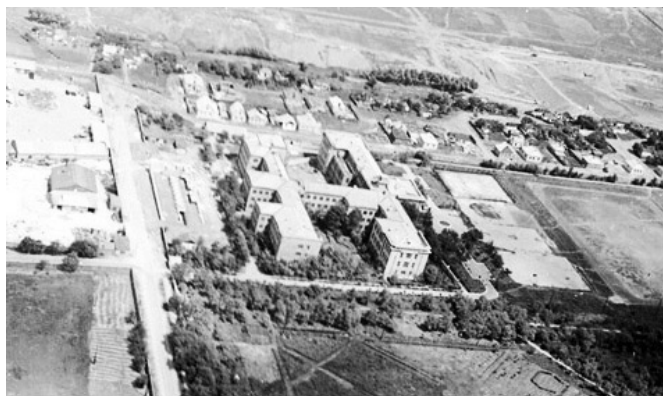
Рис. 6. Здания Сталинского медицинского института на фото 60-х годов
