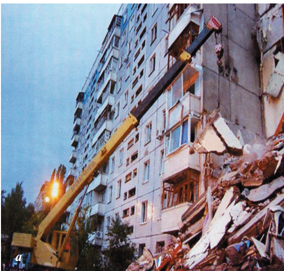
Рис. 2. Применение грузоподъемных машин при разборе завалов в Днепрпетровске (а); в Евпатории (б)
