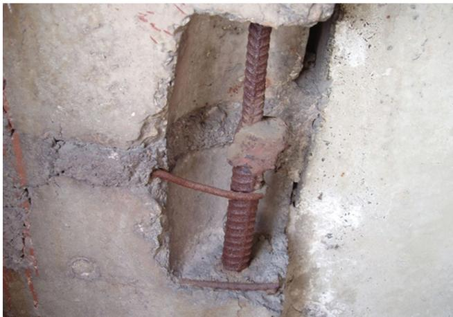
Рис. 1. Отсутствие бетона замоноличивания стыка. Несоосность стержней стыкуемой арматуры
