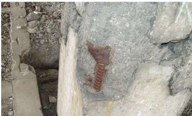
Рис. 2. Повреждение обетонированного стыка колонн. Отсутствие поперечного армирования стыка
