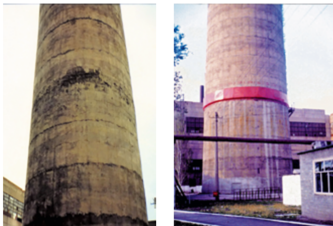
Рис. 2. Усиление части ствола дымовой трубы высотой 120 м:
