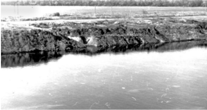
Рис. 2. Сливной отвал Макиевского и Ясиновского КХЗ
