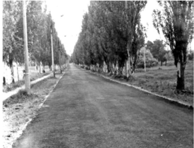
Рис. 8. Участок дорожного покрытия Константиновка-Дзержинск, построенный из влажных шлаковых смесей на кислой смолке сульфатного отделения
