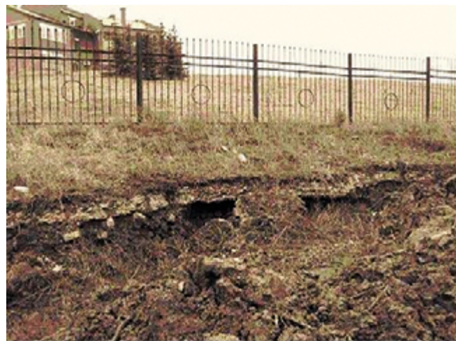
Рис. 2. Трещины и сдвиги земной поверхности в верхней зоне оползня (с. Юрьевка Донецкой области)
