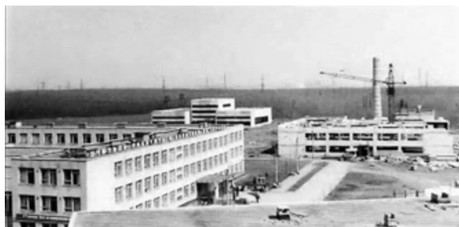
Рис. 3. Строительство новых корпусов МИСИ по ул. Державина, 2
