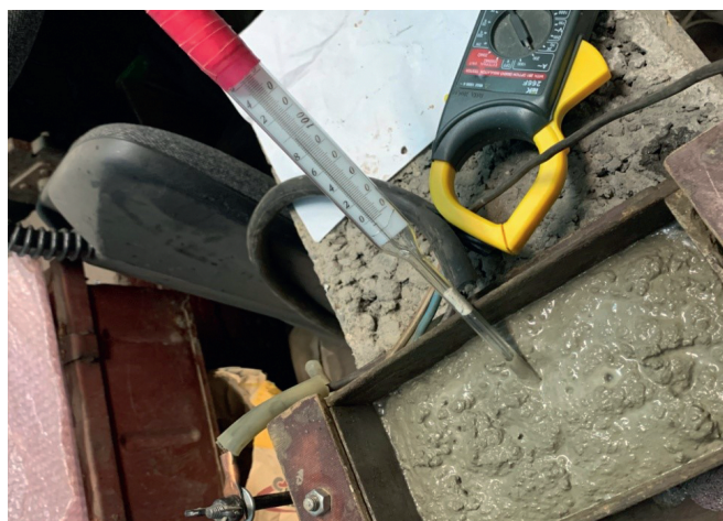
Рис. 8. Предварительный разогрев бетонной смеси
