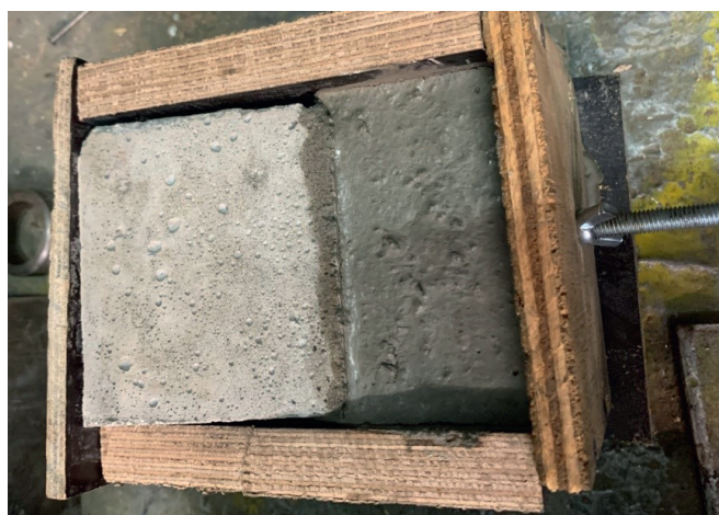
Рис. 9. Форма после укладки бетонной смеси
