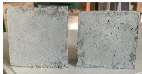
Рис. 14. Внешний вид поверхности образцов, выдержанных в агрессивных условиях и без термообработки при укладке
