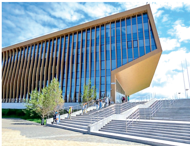
Рис. 2. Фрагмент главного входа в здание учебного корпуса Иннополиса
