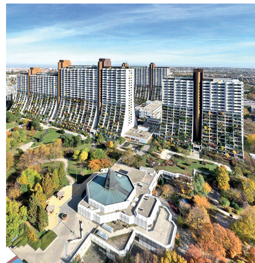
Рис. 5. Жилой комплекс «Wohnpark Alt-Erlaa» Вена, Австрия Источник: https://www.architectours.com/tour/alt-erlaa-vienna/?portfolioCats=1543
