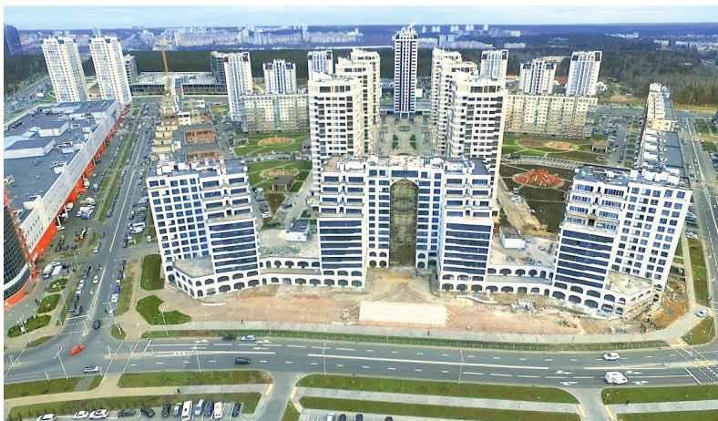
Рис. 3. Жилой комплекс «Маяк Минска», Беларусь Источник: https://carposting.ru/mayak-minska-adres/
