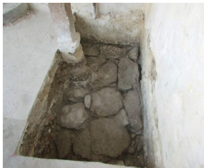
Рис. 20. Шурф 6. Фрагмент фундамента в осях К-МК/5
