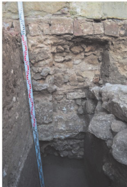
Рис. 6. Шурф 2. Фрагмент фундамента в осях Ж/4-5
