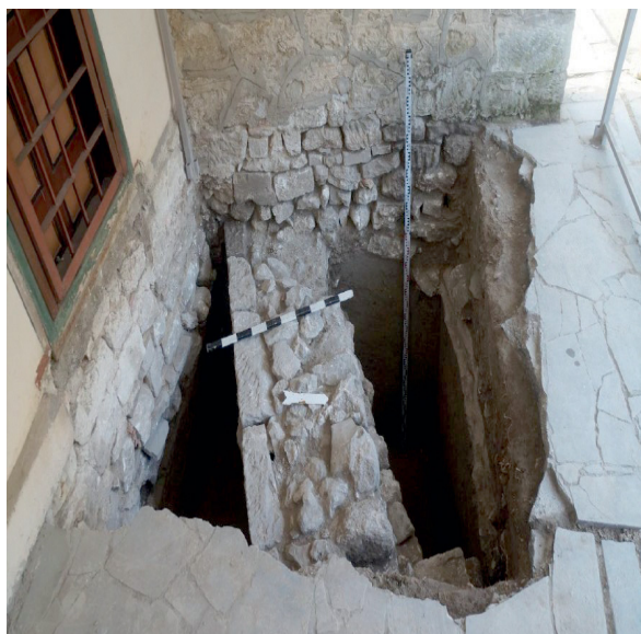
Рис. 16. Шурф 5. Фрагмент фундамента в осях Р/15
