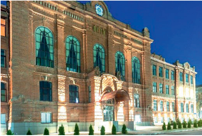
Рис. 1. Главный корпус восстановленного Приазовского государственного технического университета
