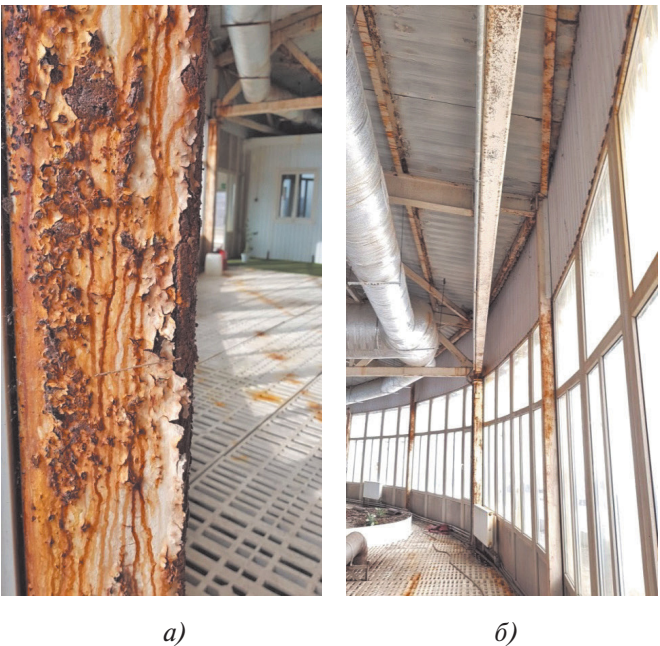
Рис. 1. Металлические конструкции, подверженные коррозии в рабочей зоне перекрытых КОС «Суворовские»: а) опорная балка; б) несущие элементы перекрытия
