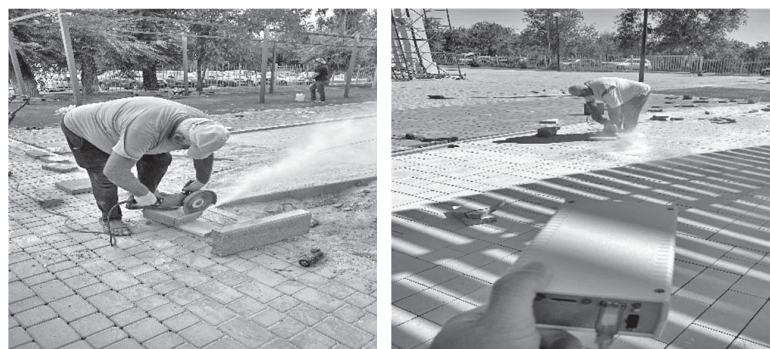
Рис. 1. Работа угловой шлифовальной машиной
