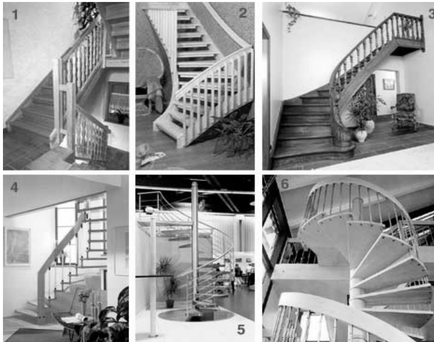
Рисунок 1. (1 – деревянная лестница на прямом косоуре, 2 – лестница на косоуре с поворотом на 90°, 3 – деревянная лестница на округлом косоуре, 4 – лестница на больцах, 5 – винтовая лестница, 6 – винтовая спиралевидная лестница)
