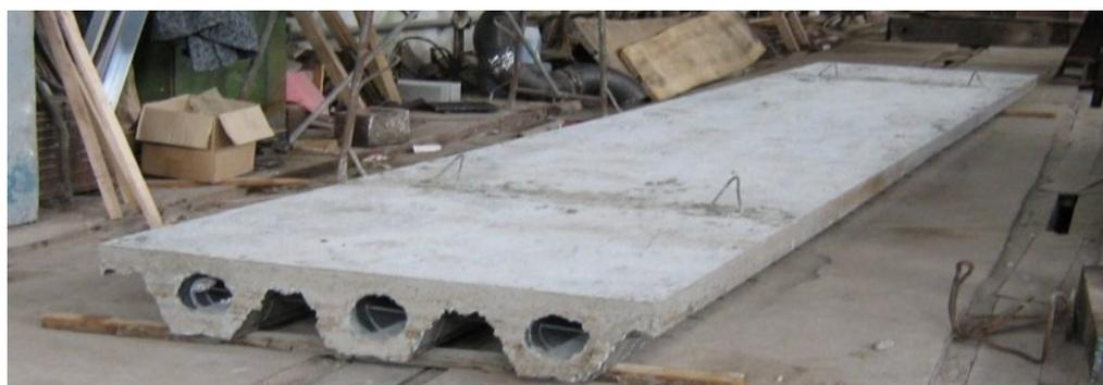
Рисунок 3 – Пустотно ребристая плита после преднапряжения арматуры.
