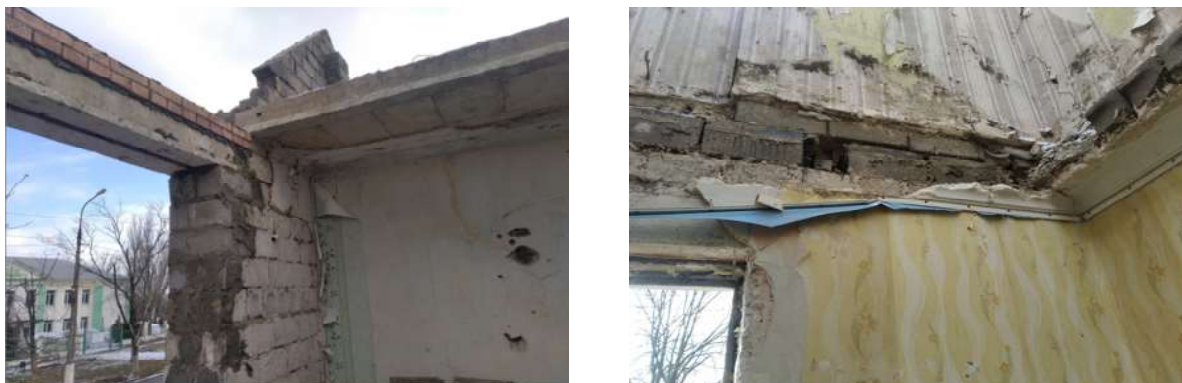
Рисунок 2 – Разрушение отдельных участков чердачного перекрытия.
