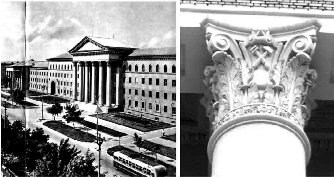
Рисунок 7 – Комплекс ДонУГИ. Капитель колонны центрального портика главного входа.
