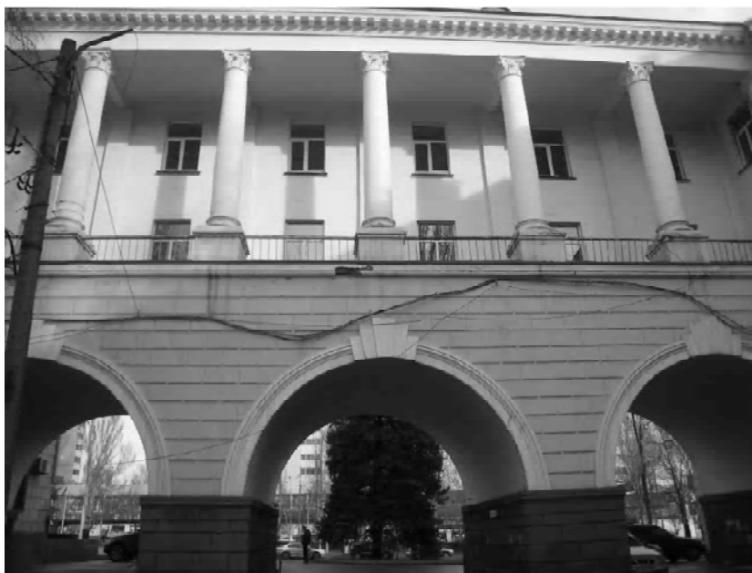
Рисунок 3 — Фрагмент фасада здания Донецкой клинической травматологической больницы со стороны улицы Университетской. Ритмический ряд колонн коринфского ордера верхней части здания удачно контрастирует с его нижним ярусом, который включает в себя широкие арочные проемы и выраженную текстуру наружной отделки.
