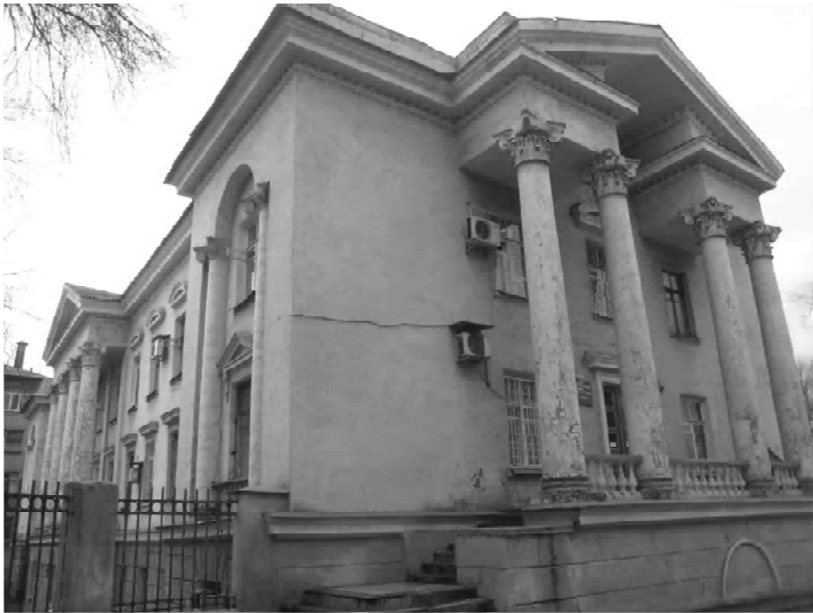
Рисунок 4 – Внешний облик здания водолечебницы (больницы №5 в г. Донецьке), запроектированного в стиле послевоенного классицизма. Вид со стороны бульвара Пушкина.
