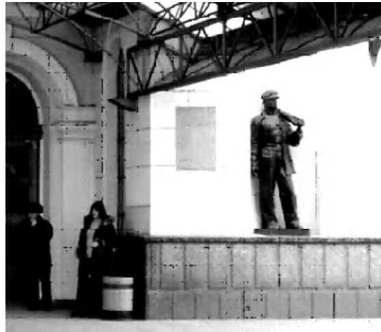
Рисунок 9 — Фрагмент фасада здания железнодорожного вокзала в г. Донецке.
