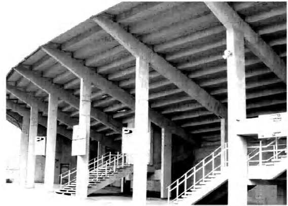
Рисунок 11 – Фрагмент подтрибунного пространства стадиона "Шахтер".
