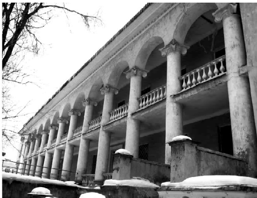
Рисунок 5 – Вид больницы № 5 со стороны улицы Университетской. Усиленный ритм колонн, имеющие циркульные арочные завершения, визуально облегчают фасад больничного учреждения, придают ему торжественность и выразительность.
