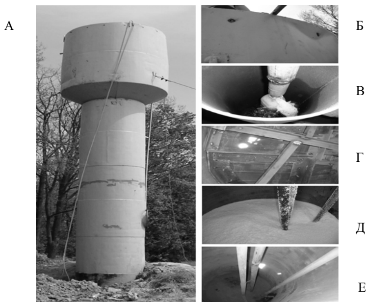
Рисунок 2 — Загальний вигляд башти та її деталей: А) водонапірна металева башта; Б) трубопровід подачі вихідної води; В) повітровідділювач; Г) утримуюча решітка; Д) пінополістирольна засипка; Е) розміщення трубопроводів.
