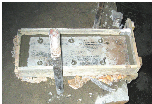
Рисунок 3 — Подливка опорных стальных плит составами ЕМАСО® S33 и модифицированного тонкозернистого бетона с ОММ-2.
