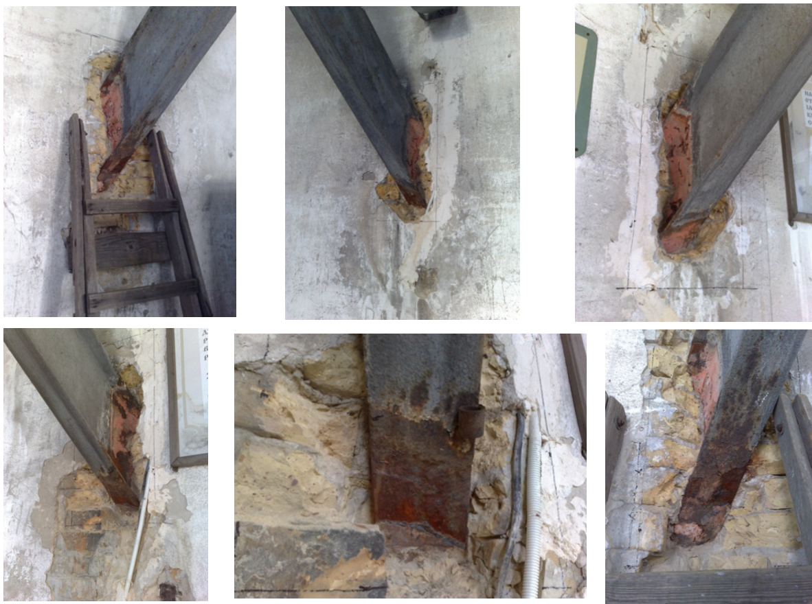
Рисунок 2 – Зовнішній стан кінців металоконструкцій після викриття штукатурки та цегляної кладки
