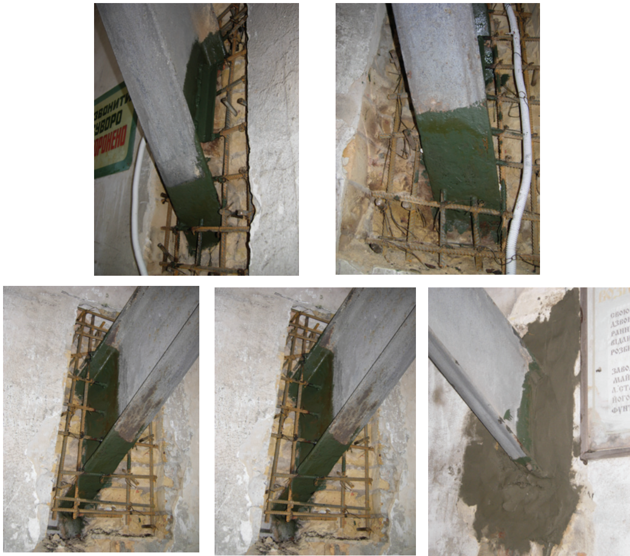
Рисунок 3 — Нанесення захисного покриття на кінцівки металоконструкцій.
