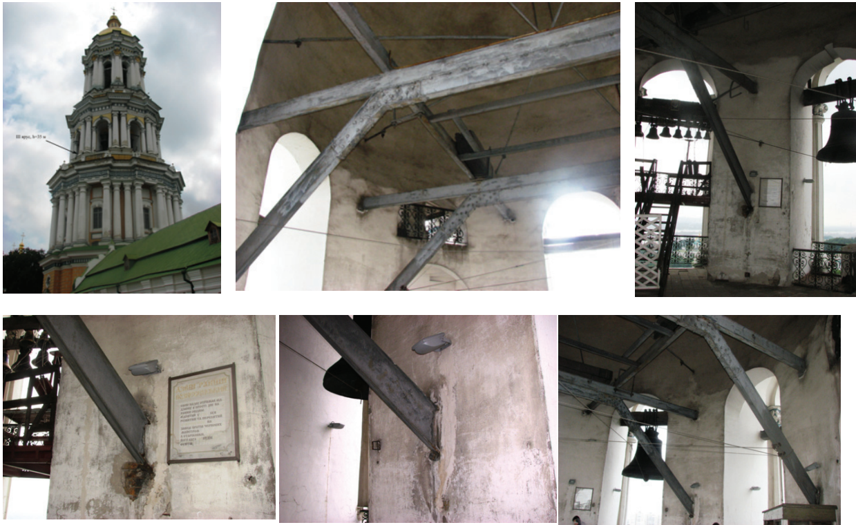
Рисунок 1 – Зовнішній вигляд дзвіниці та металоконструкцій, які кородували під дією вологої атмосфери
