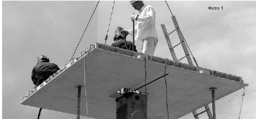
Фото 1 – Монтаж надколонной плиты.
