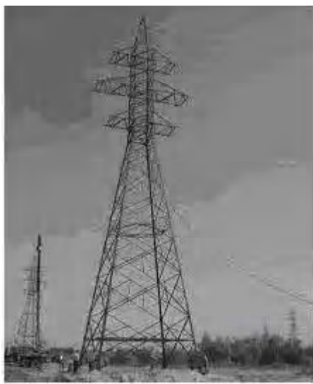
Рисунок 2 – Общий вид оптимальной опоры У110-2+14.
